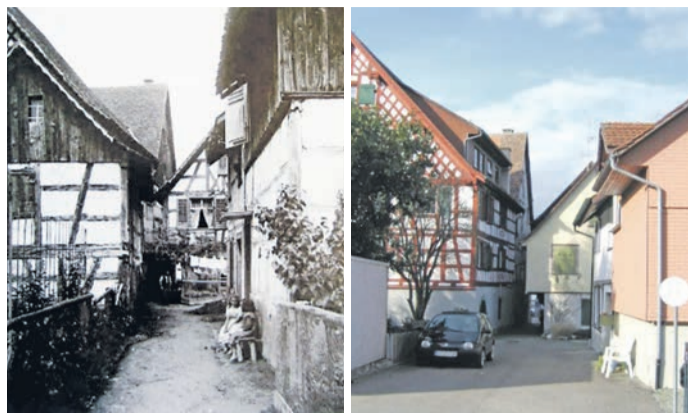
Ein Berlanghaus? Mannwerk 18/20 in der Gerbegasse (rechts) 1910 und 110 Jahre später.
